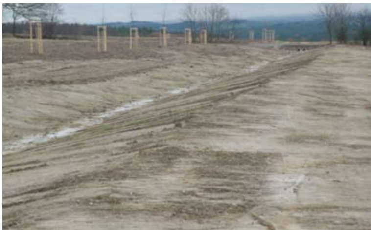
Zasakovací průřeh uprostřed svažitého půdního bloku jako ochrana proti bleskovým povodním, které ohrožují zastavěnou část obce, zvyšuje retenci vody v krajině, rozděluje nevhodnou velikost bloku orné půdy a nepřerušovanou délku svahu způsobující erozi půdy. (Hromnice Plzeň sever 2014)
