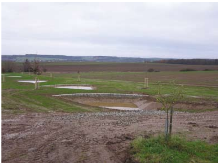
Soustava 6 vsakovacích jam na revitalizovaném trubním odpadu z výše položeného půdního bloku orné půdy, který je odvodněn systematickou drenáží ( Hněvnice, Plzeň-sever, 2015)
